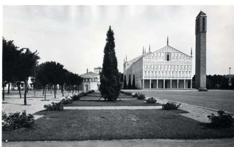
La chiesa di S. Barbara a Metanopoli (Milano)
